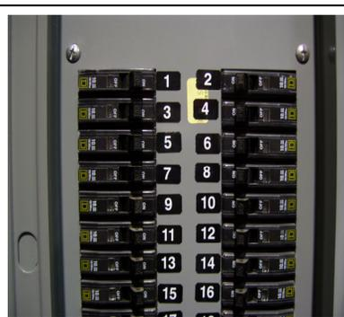
CHECK CIRCUIT BREAKERS TO DETERMINE THE AMPERAGE CAPACITY FOR EACH CIRCUIT
